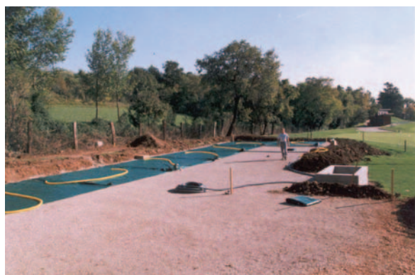
Posa dei tubi di drenaggio nel green
