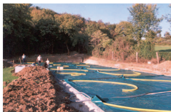
Tubi di drenaggio collocati nel green
