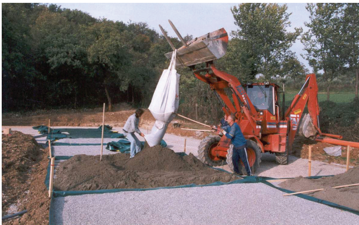
Allestimento dei topsoil nel green
